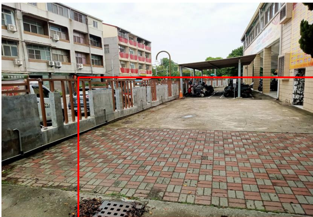
預備會勘設站地點及備用腳踏車儲放地點(圍牆邊長 10 公尺、至泳池寬 3.5 公尺)
